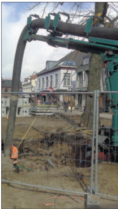
De werkzaamheden aan het Wilhelminaplein zijn in volle gang.
