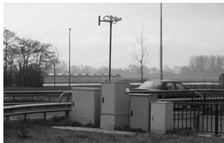
Deze schakelkasten in Koudekerke verwerken het aantal auto's. In de spits staat de openbare verlichting op honderd procent. Neemt het aantal auto's af, dan krijgt de schakelkast een signaal dat het licht mag dimmen. Bij regen en mist geeft de regen- en mistdetector aan dat de verlichting op honderd procent moet staan.
